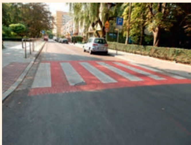
Ulica Litewska – chodnik i nowa nawierzchnia
