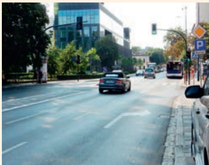
Ulica Czarnowiejska – chodnik, zatoka parkingowa i nowa nawierzchnia
