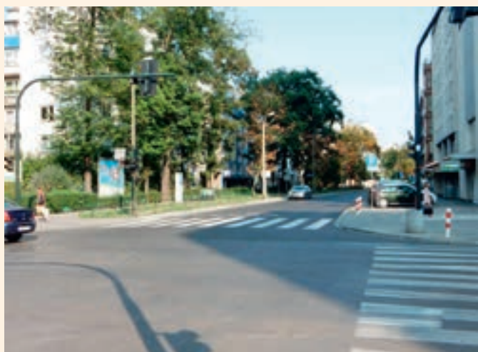
Ulica Kazimierza Wielkiego – nowa nawierzchnia
