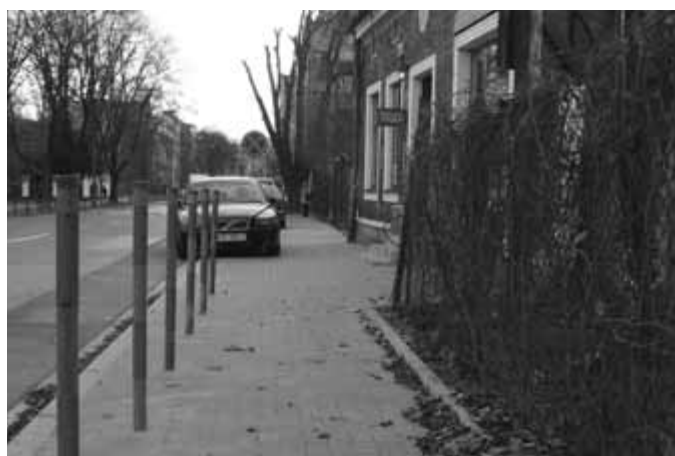
Ulica Kazimierza Wielkiego – remont chodnika
