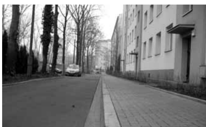
Ulica Zakątek – remont chodnika i jezdni
