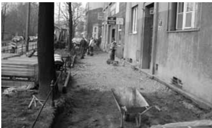
Ulica Czarnowiejska – remont chodnika
