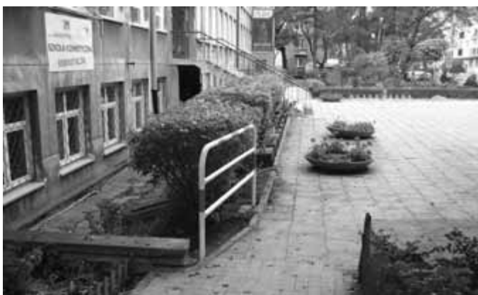
Gimn. nr 17 przy ul. Litewskiej 34 – remont chodnika
