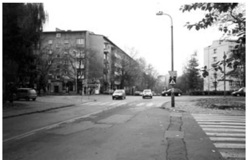
Umieszczenie sygnalizacji świetlnej na skrzyżowaniu ulic: Smoluchowskiego, Podchorążych, Królewska, Kazimierza Wielkiego, 365 000 zł
