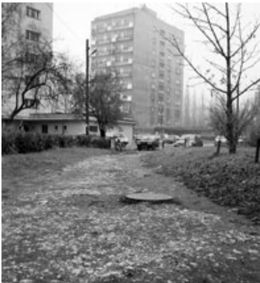
Budowa chodnika, ul. Chocimska, 40 000 zł
