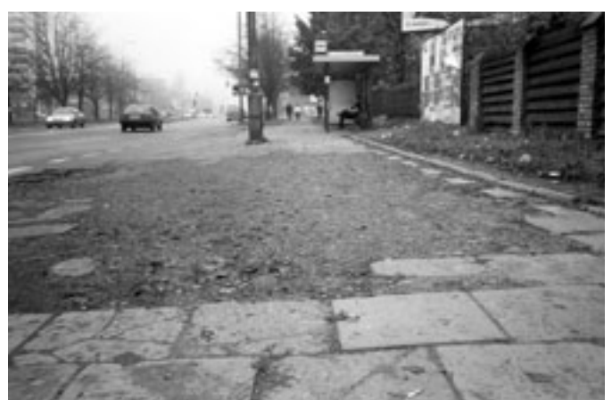
Remont chodnika, ul. Nawojki, 72 000 zł
